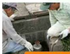
給水栓の点検
