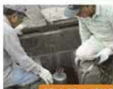
給水栓の点検
